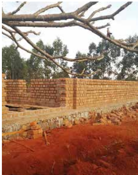
Die Fertigstellung der Halle für das VTC St. Monica wird sehnsüchtig erwartet
