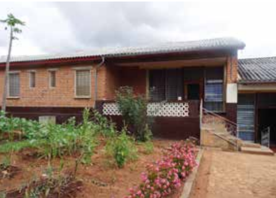
Das Schwesternhaus in Ruhuwiko, das momentan renoviert wird
